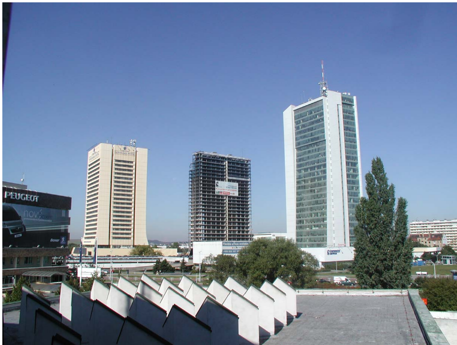
CITY TOWER – DEMONTÁŽ PLÁŠTĚ
