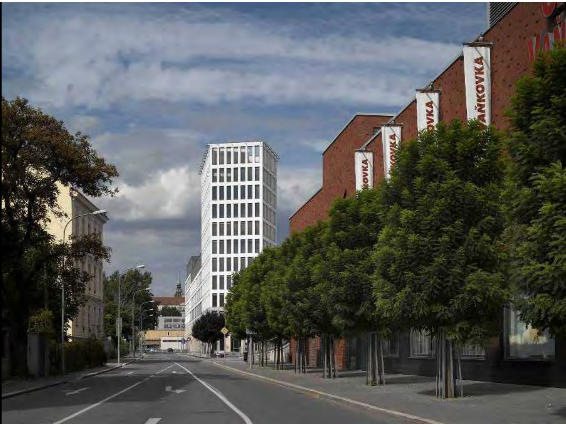
Obchodní galerie Vaňkovka a administrativní centrum Trinití, Brno
