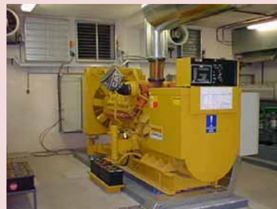
Dieselaagregát ve vysílači Praha-Žižkov
