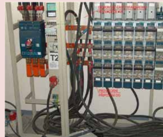
Rozváděč NN – příprava na připojení DA
