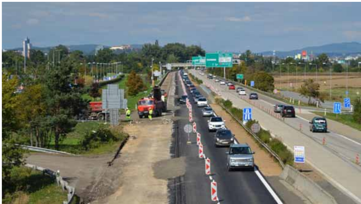
Oprava dálnice D2 u Brna
