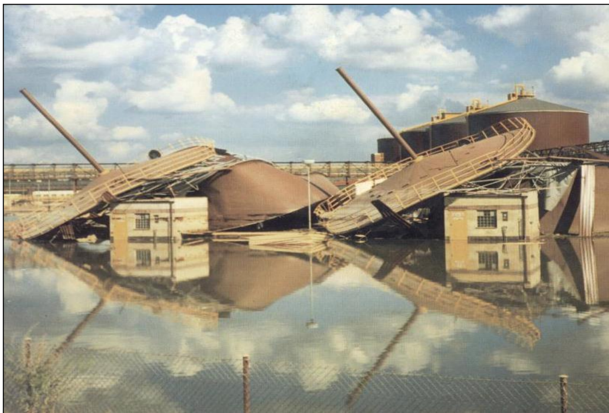
Následek povodně na objekt technické infrastruktury
