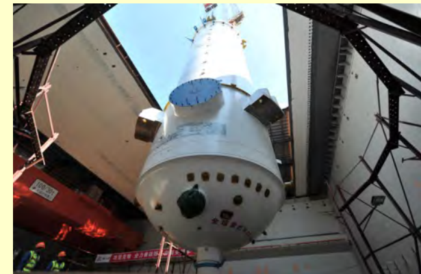
Instalace reaktoru HTR-PM v Číně
