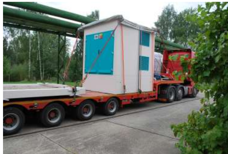
Trafokiosek + rozvaděč VN
