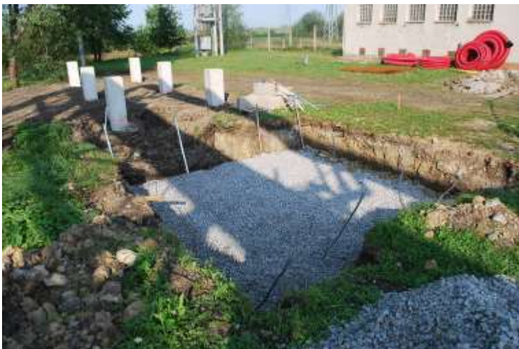
Práce na stavební připravenosti
