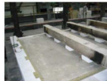
Obr.5 Pohled na zatížený strop
