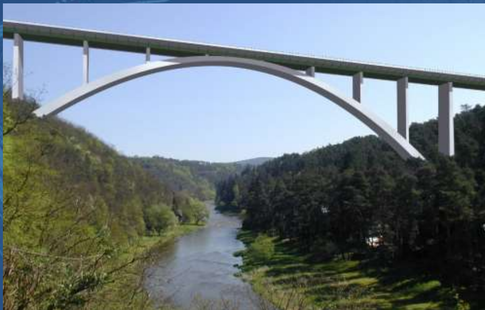
Most Sázava – délka 784 m, výška mostu 110 m
