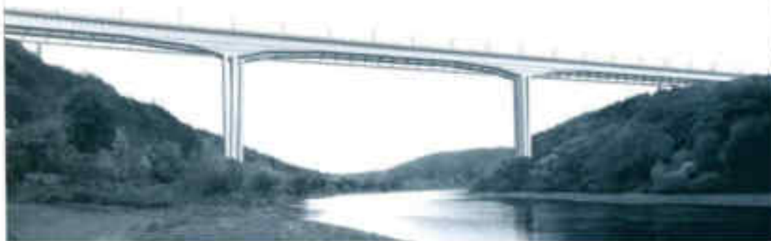
Obr. 8a Letmo betonovaný betonový předpjatý most (provoz pěších v dolní úrovni)
