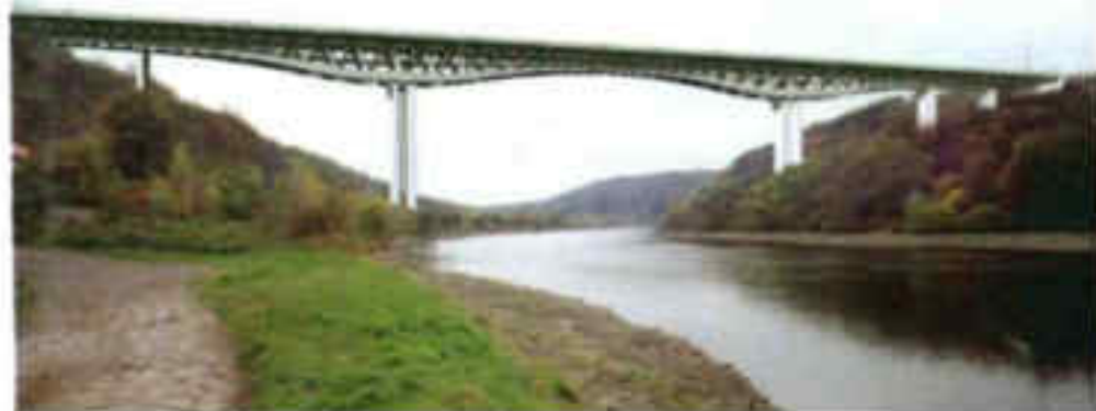
Obr. 11 Ocelobetonový spřažený trémový most s náběhy (provoz pěších v horní úrovni)
