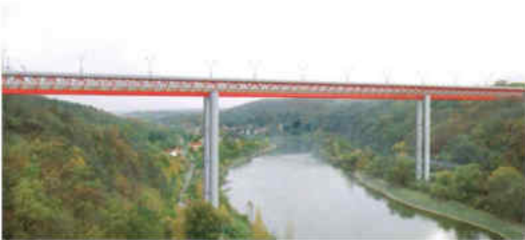
Obr. 10a Ocelobetonový spřažený trémový přímopásový most (pěší v dolní úrovni)
