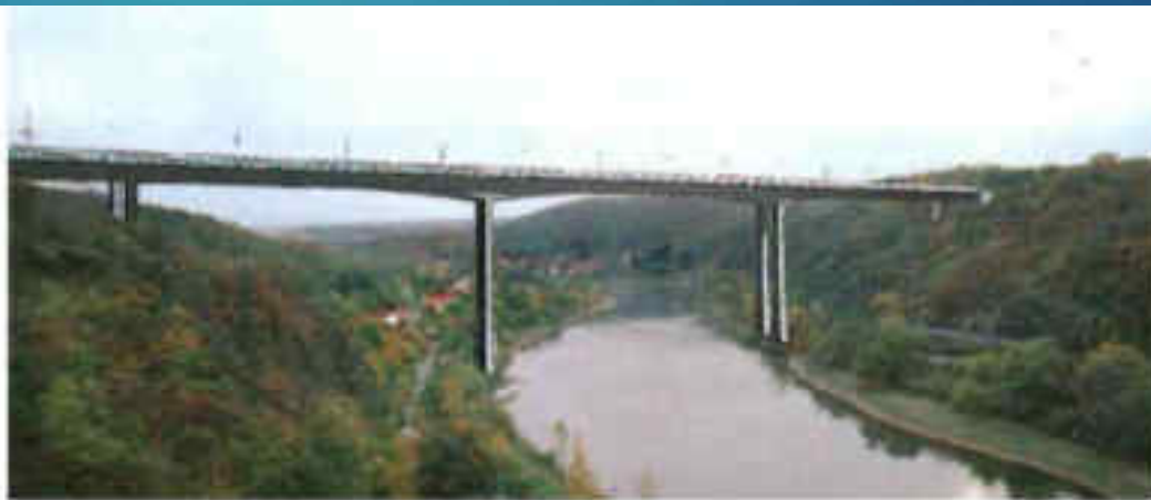
Obr. 9 Letmo betonovaný předpjatý most (provoz pěších v horní úrovni)
