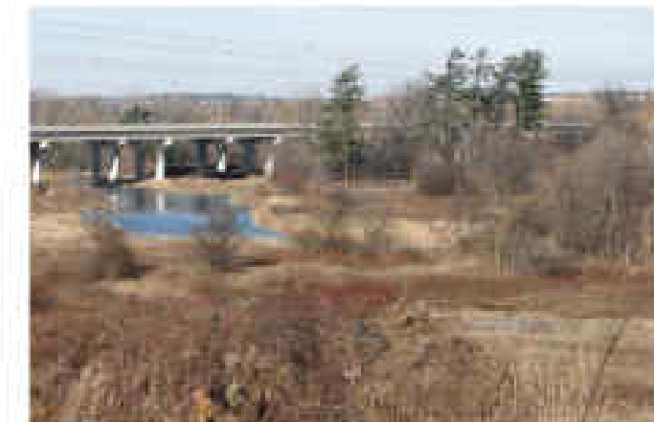
retenční nádrž pod mostním objektem / zdroj: www.wikipedia.org
