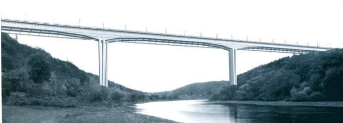
Obr. 8a Letmo betonovaný betonový předpjatý most (provoz pěších v dolní úrovni)
