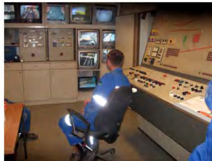
podzemní řídicí středisko úpravny
