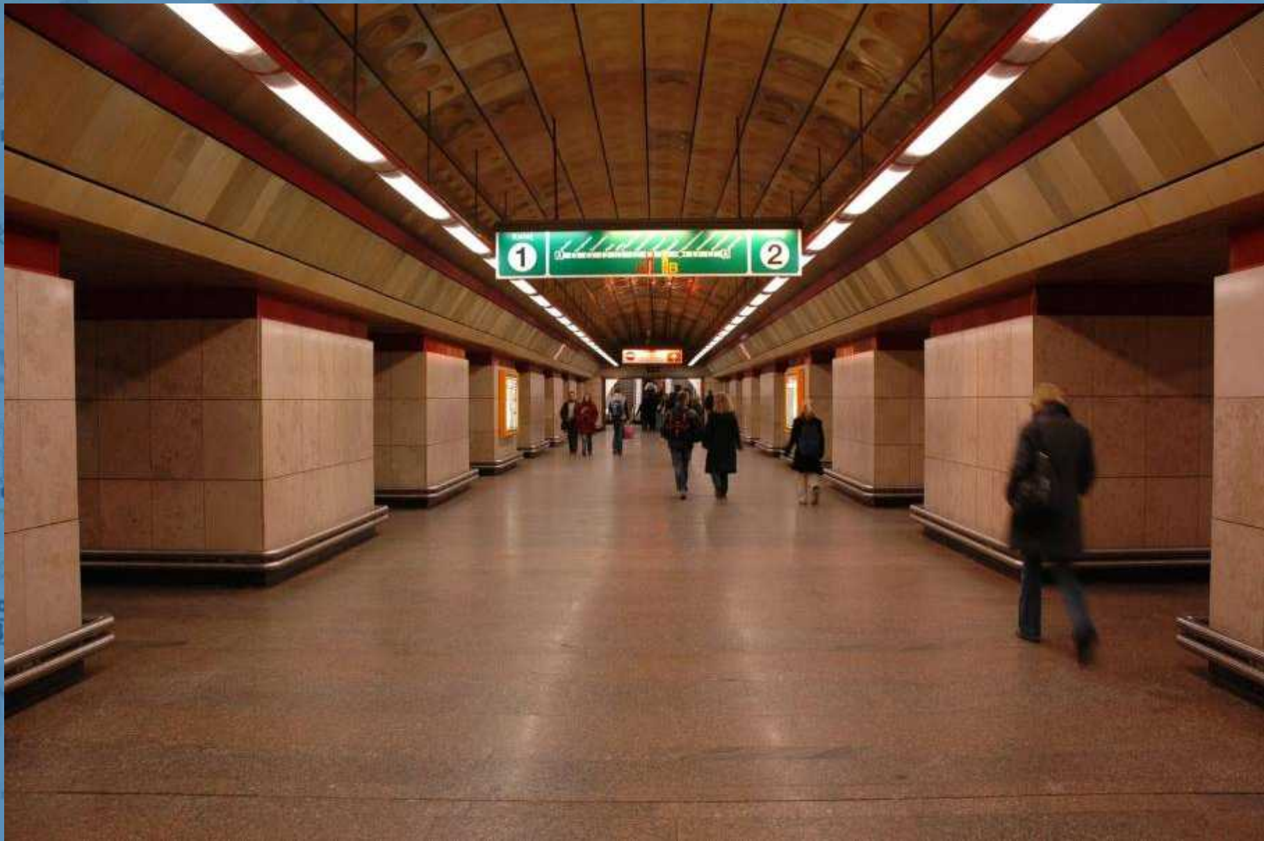
I.A tunel pod Vltavou, ražené trojlodní stanice s objemnými pilí i
